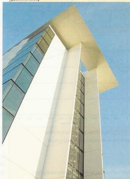
Exemple de bâtiment réalisé à l'aide d'un béton aux capacités photocatalytiques : tour Headlight à Labège (31). Dain Saladin, architecte.
