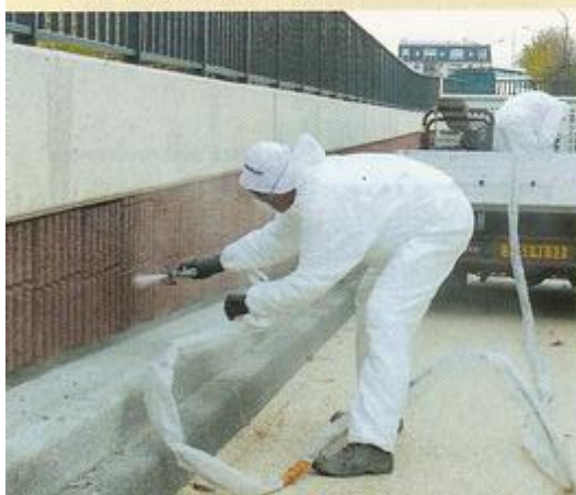
Application d'un revêtement photocatalytique sur panneaux acoustiques.
